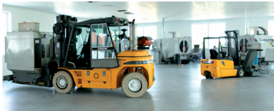
Die Einrichtung der neuen Halle ist im vollen Gange.
